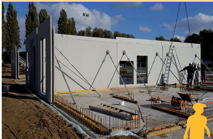
▲ Eind oktober werden de eerste prefabmuren van het nieuwe gebouw geplaatst.
